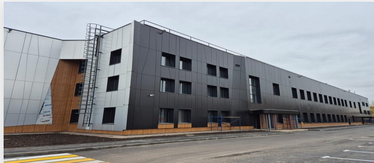
Склад и офис UNIPUMP, Балашиха
